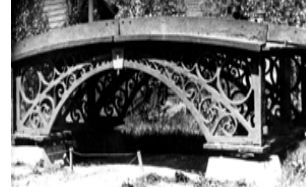
Öntöttvas híd a Fekete-Garamon. Rónicon készült, 1810-ben
